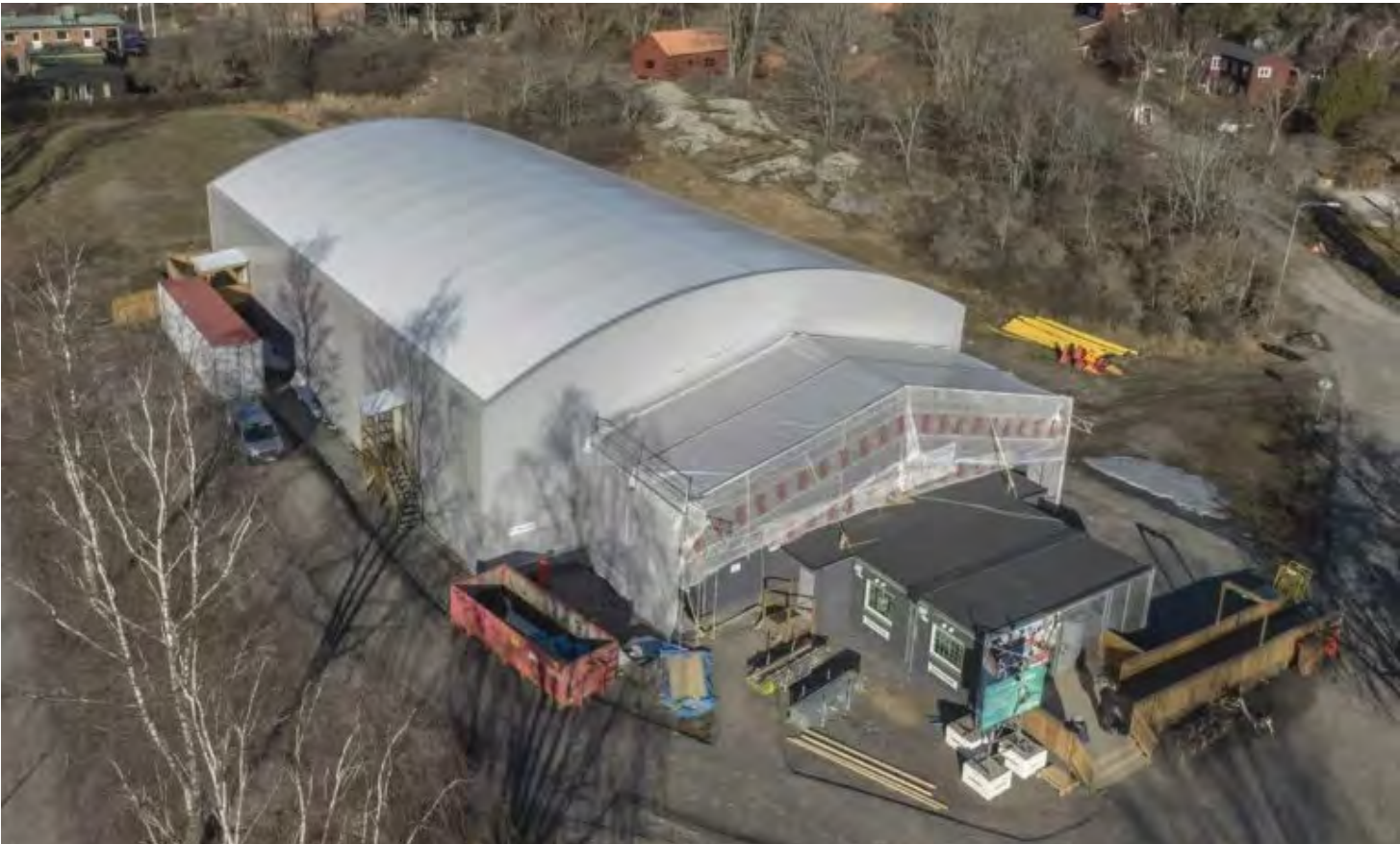
Referensexempel; Näckenbadet tillfällig simhall. Badet består av en tältkonstruktion som innehåller bassängrummet. Baracker dockar an och innehåller entré och omklädning.
